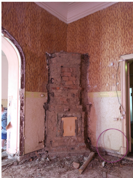
Рис. 49. Остов печи, керамические изразцы демонтированы (Санкт-Петербург, Английский пр., д. 4–6; автор фото К. Ю. Губинская, 2017 г.)
