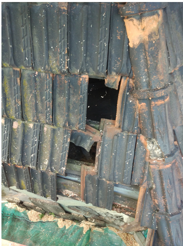
Рис. 45. Фрагмент черепичной кровли с утраченными элементами (Санкт-Петербург, Английский пр., д. 8–10; автор фото К. Ю. Губинская, 2016 г.)
