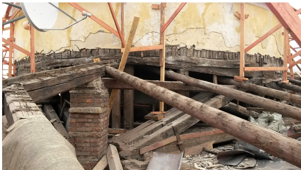
Рис. 44. Фрагмент конструкций крыши при производстве реставрационных работ (Санкт-Петербург, ул. Союза Печатников, д. 22; автор фото К. Ю. Губинская, 2016 г.)
