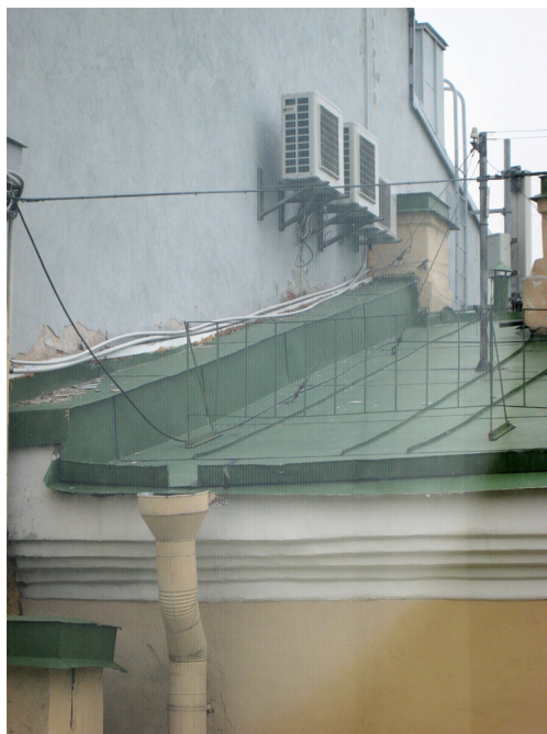
Рис. 46. Фрагмент кровли (Санкт-Петербург, Галерная ул., д. 7; автор фото К. Ю. Губинская, 2016 г.)
