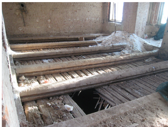
Рис. 40. Межэтажное перекрытие по деревянным черепным балкам, чистовой пол, лаги и межбалочное заполнение демонтированы, сохранен нижний подшив потолка (Санкт-Петербург, Адмиралтейская наб., д. 15; автор фото К. Ю. Губинская, 2015 г.)
