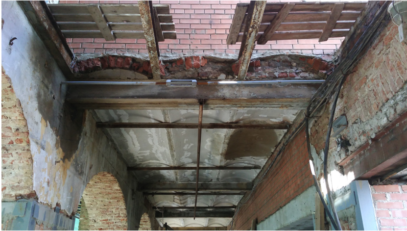
Рис. 42. Кирпичные сводики по металлическим балкам, процесс демонтажа конструкций в неудовлетворительном состоянии (Санкт-Петербург, Садовая ул., д. 62; автор фото К. Ю. Губинская, 2015 г.)
