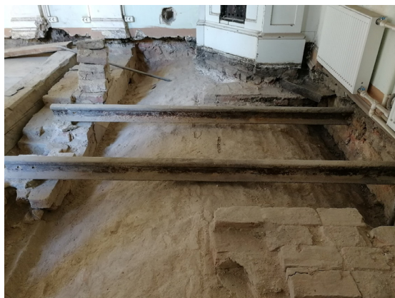
Рис. 41. Вид раскрытого свода перекрытия и исторического устройства покрытия пола по металлическим рельсам (Санкт-Петербург, наб. р. Мойки, д. 86–88; автор фото К. Ю. Губинская, 2018 г.)
